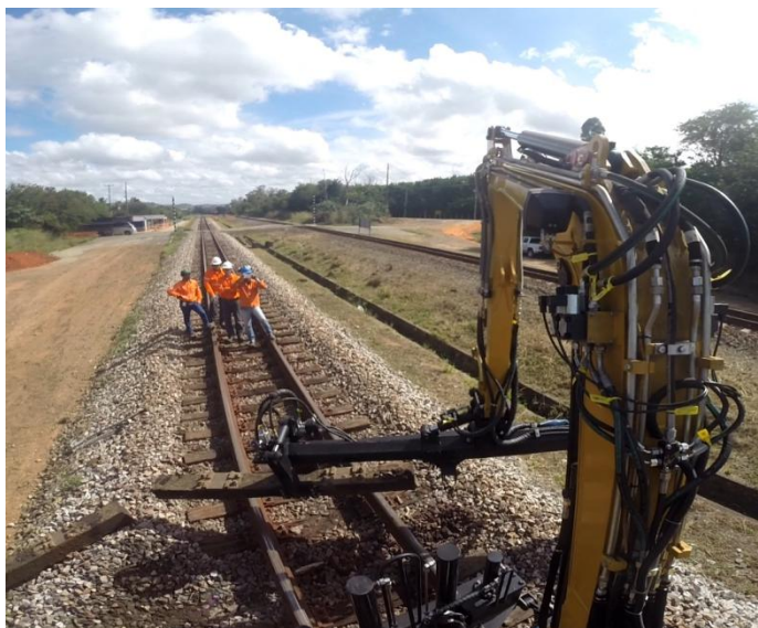
Visão do operador durante teste de troca de dormentes
